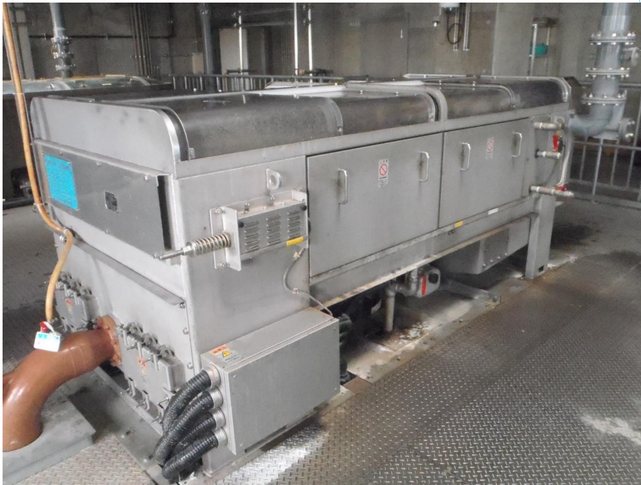
新田浄化センター№2機械濃縮設備機械工事
