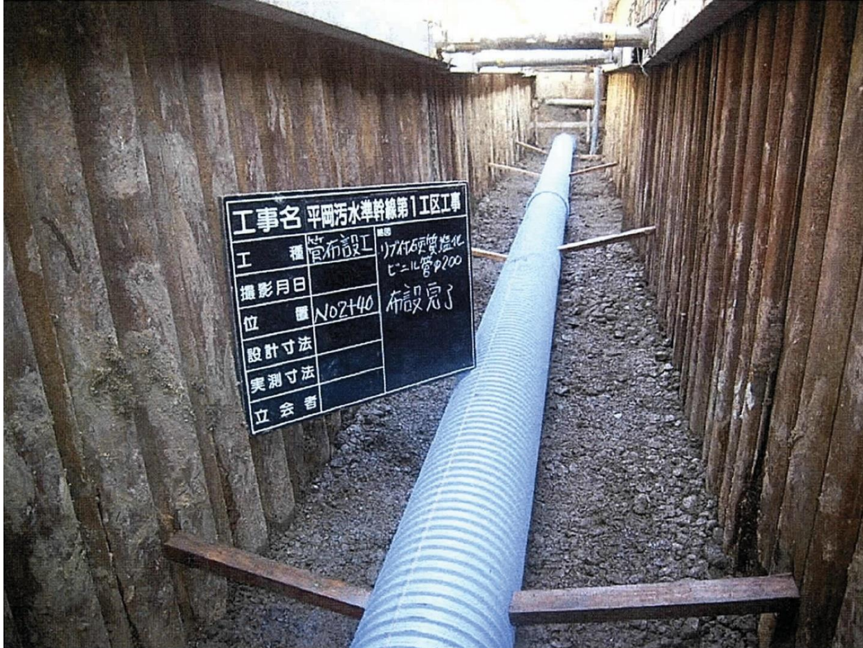
平岡污水準幹線第1区工事
