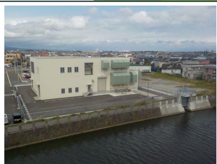
富田ポンプ場（H31.4供用開始）
