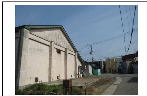
⑫から撮影した写真
