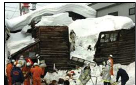
写真 雪の重みで倒壊した家屋
