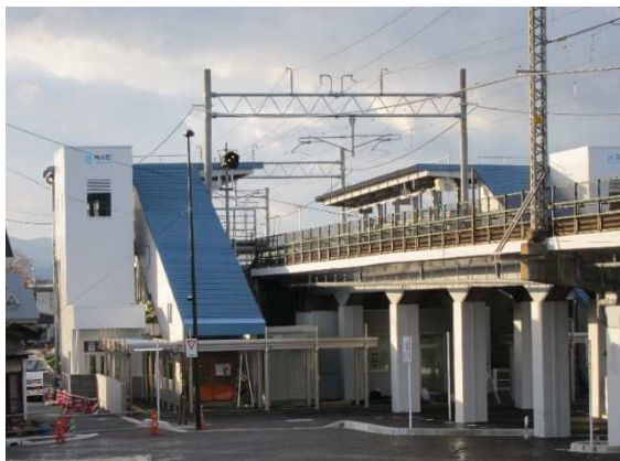
写真 筒井駅 (H26.3月開業)
