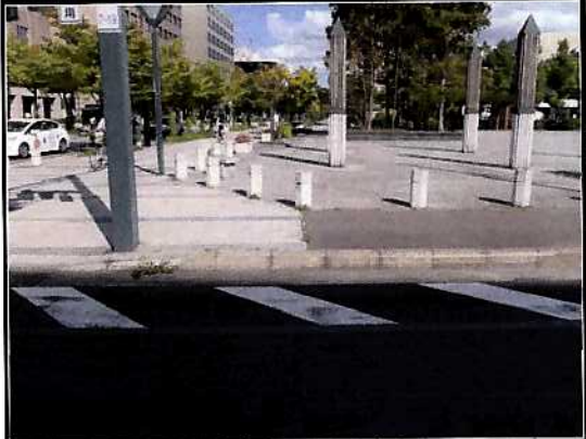
図書館通り舗装状況
