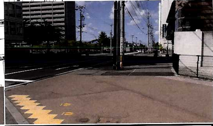
国道4号舗装状況
