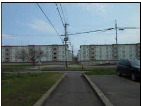
から撮影した写真
