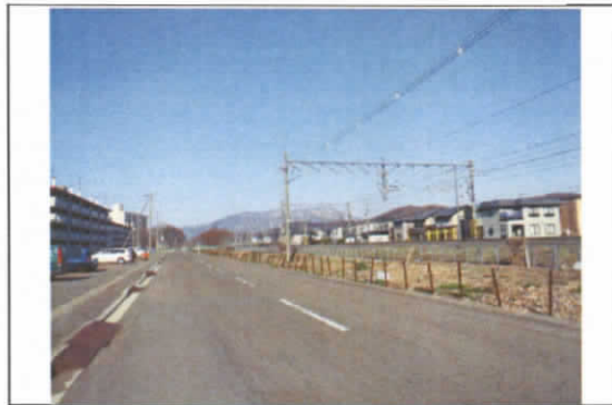
⑪から撮影した写真
