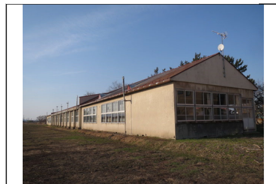
⑪から撮影した写真
