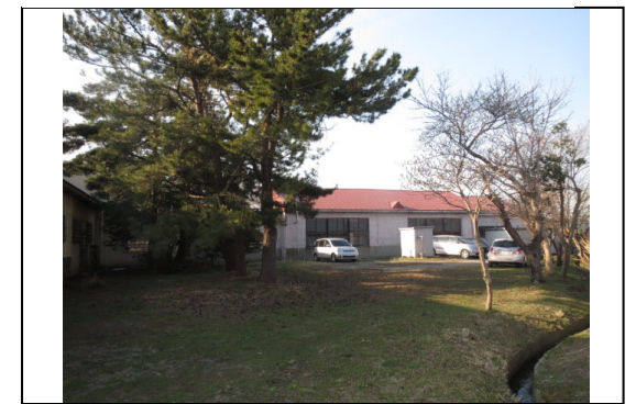
⑧から撮影した写真
