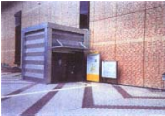
図 バリアフリー設備の例(エレベーター)
