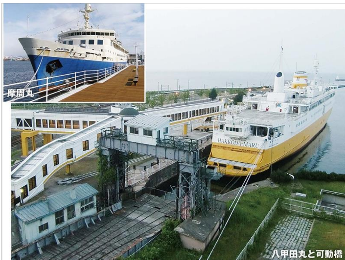
図 参考 45 青函連絡船及び可動橋
