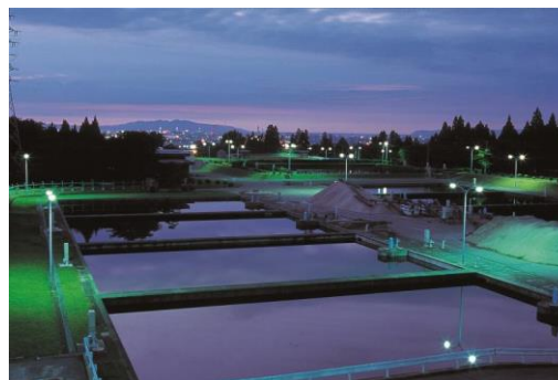
図 参考 59 横内浄水場の夜景
