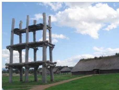
図 参考 38 復元大型掘立柱建物
