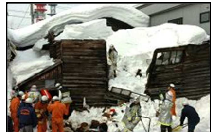
写真 雪の重みで倒壊した家屋
