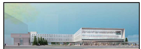
青森市役所本庁舎（新市庁舎）の整備
