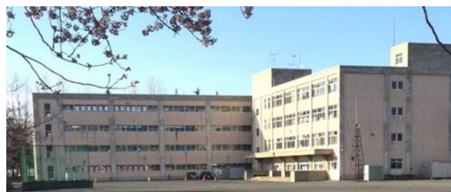
造道小学校 (現況)
