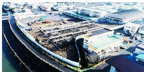
筒井小学校 (令和 3 年 11 月撮影)
