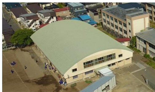
西中学校 屋内運動場 (現況)
