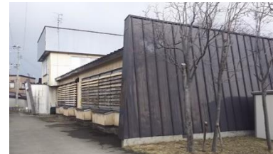
造道福祉館（現況）
