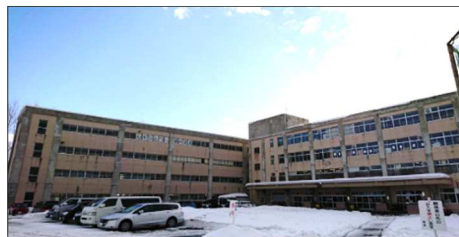
造道小学校（現況）
